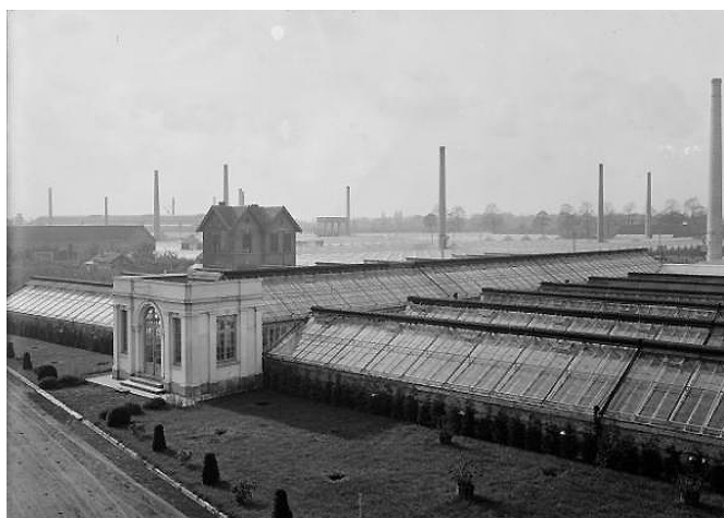
Het bedrijf gelegen naast de huidige Baron Ruzettelaan omvatte ettelijke hectaren serres en kon zich met fierheid het grootste hofbouwkundig bedrijf ter wereld noemen. Stadsarchief Brugge (www.beeldbankbrugge.be), verz. Brusselle-Traen
